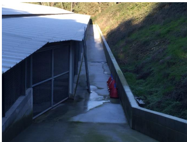
Figura 2.2 – Conduta em meia cana de condução de águas pluviais entre a parte norte da instalação e a área impermeabilizada lateral do pavilhão 2
