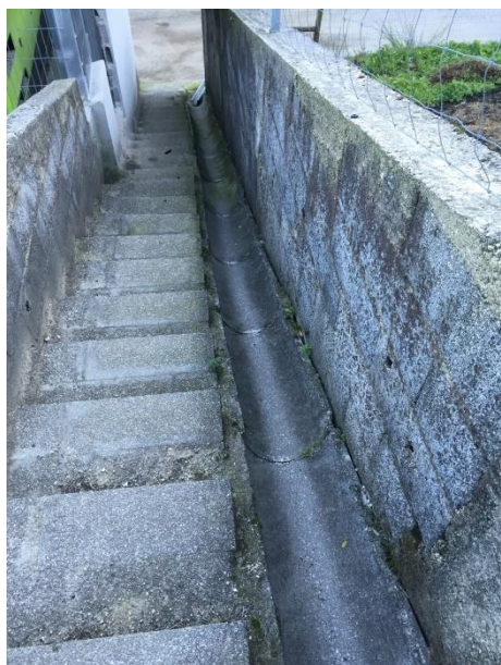
Figura 2.3 – Conduta em meia cana de condução de águas pluviais entre a parte norte da instalação e lateral do pavilhão 2
